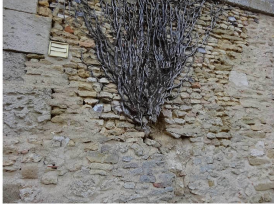
La reconstruction des éléments maçonnés
